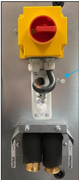
**Hauptschalter** für den elektrischen Anschluss
