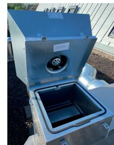
Bild rechts: Der EC-Motor ist für Reinigungs- & Reparaturzwecke aufklappbar.
