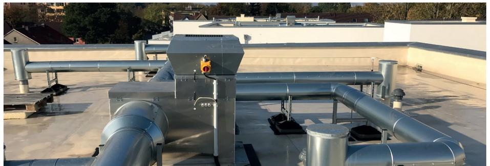
Bild oben: Die Dachlüftungsgeräte der Baureihe DVSAxx-Axx sind mit unterschiedlichen Anschlussmöglichkeiten erhältlich: Kanal- oder Rohranschluss von unten, seitlich (2x) oder stirnseitig. Die Anschlussstützen können flexibel an- und umgebaut werden, sodass die Anschlüsse auch vor Ort optimal an die Ausrichtung der Rohrleitungen auf dem Dach angepasst sind.
