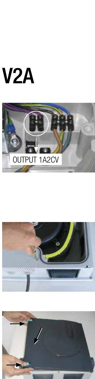
15. Darauf achten, dass das Lüftungsgerät auf dem Sockel in der Mitte richtig einrastet.
